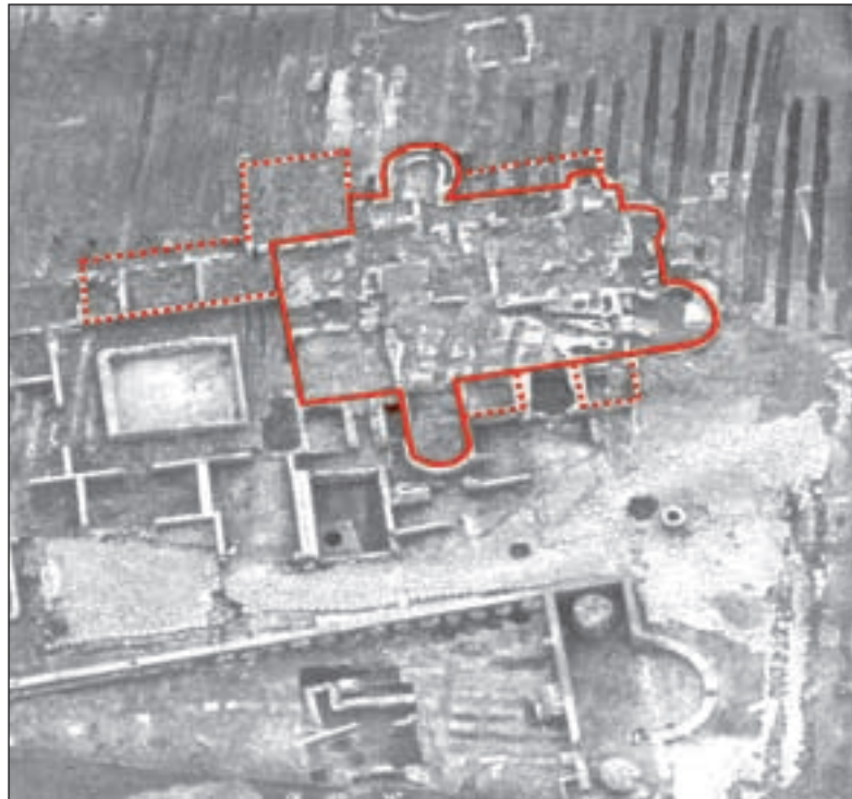
Figura 7. Particolare della fotografia aerea dell'area di scavo: il basolato stradale divide la cella vinaria dalle terme: la linea rossa indica il perimetro dell'impianto termale, la linea tratteggiata il suo ultimo ampliamento
